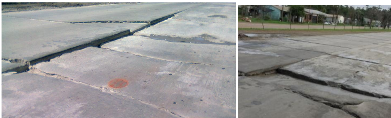
Figura 9.1: Estado del pavimento rígido la Ruta Nac. 127
