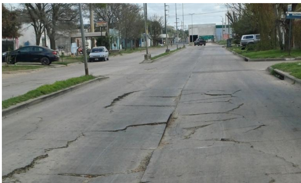
Figura 1.4: Estado del pavimento rígido en Av. Avellaneda por donde circula el tránsito pesado
