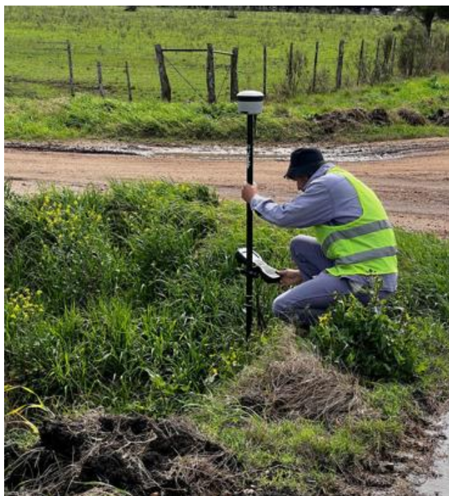
Figura 5.2: Levantamiento de perfiles transversales
