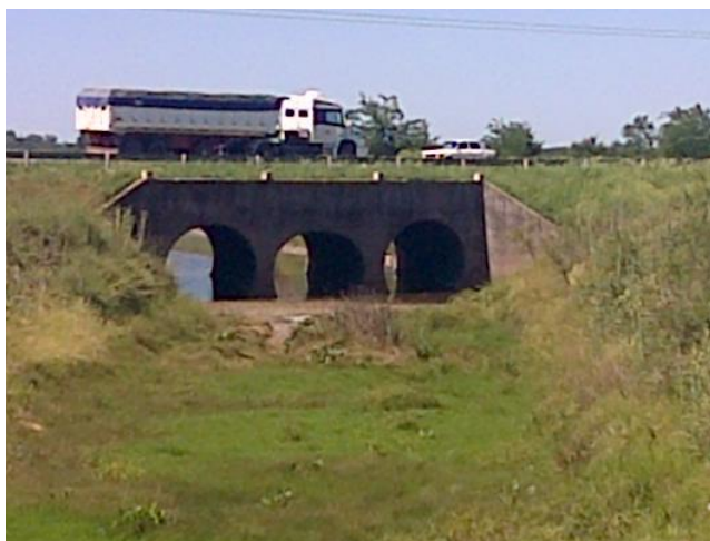
Figura 8.5: Aliviador en RN12-Tunel Liner
