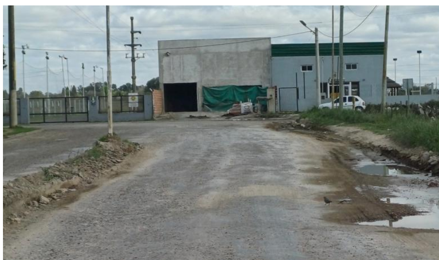
Figura 1.5: Pavimento deteriorado en Av. Avellaneda y Ejército Argentino
